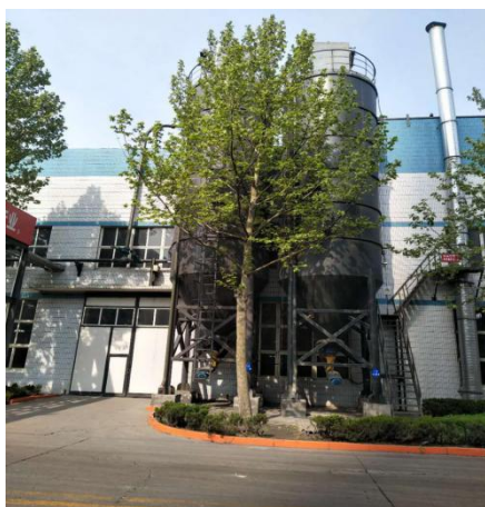
复合自保温砌块粉煤灰罐、水泥罐
