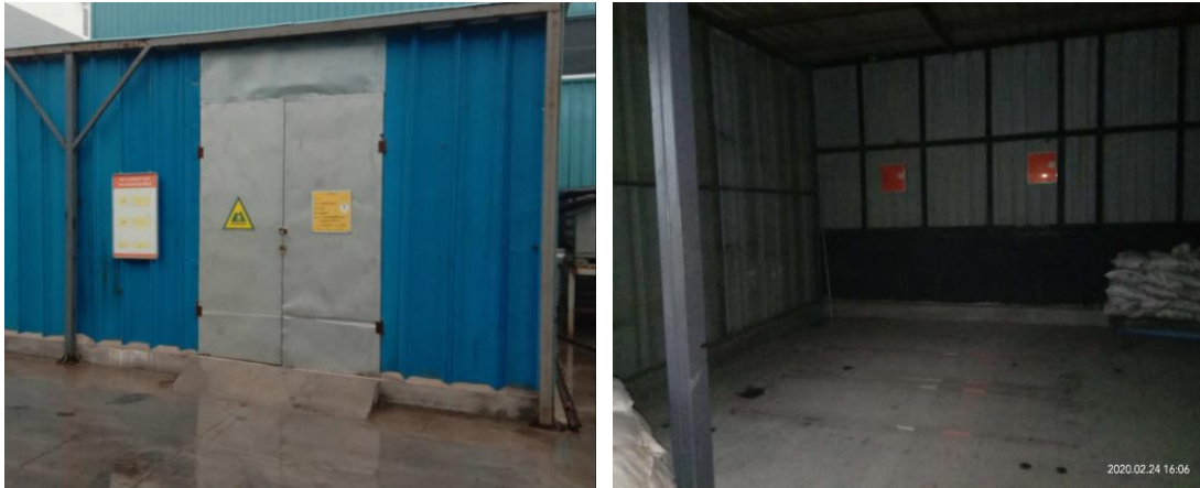
现有工程危废暂存间内外照片
