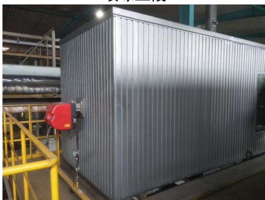
现有工程天然气燃烧器
