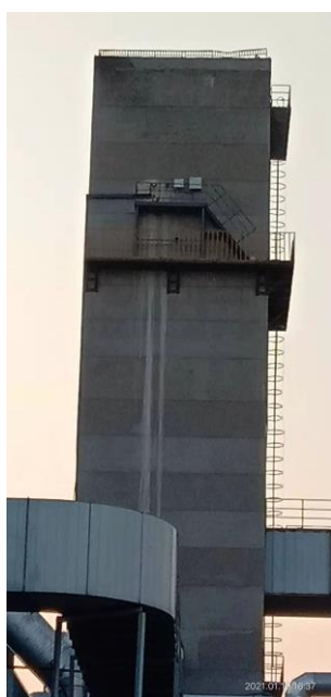
现有工程 P1-1 排气筒及采样平台
