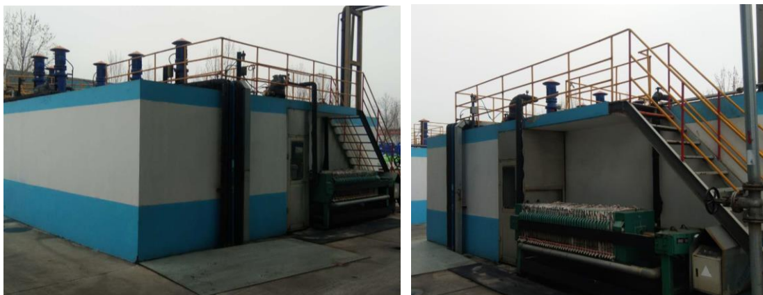
现有工程磷化废水处理站现状
